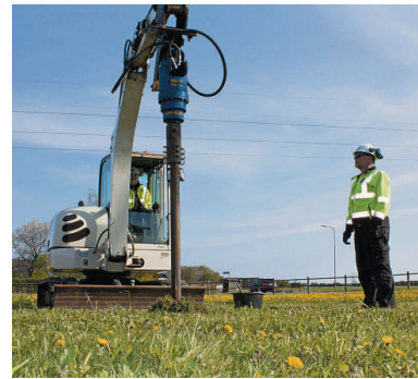
■ Demonstration af, hvor enkelt det er for Uretek-folkene at fundere med ScrewFast Skrupepæle. Virksomhedens egen plæne tog imod, da fynske erhvervsfolk fik et indblik i konceptet.
