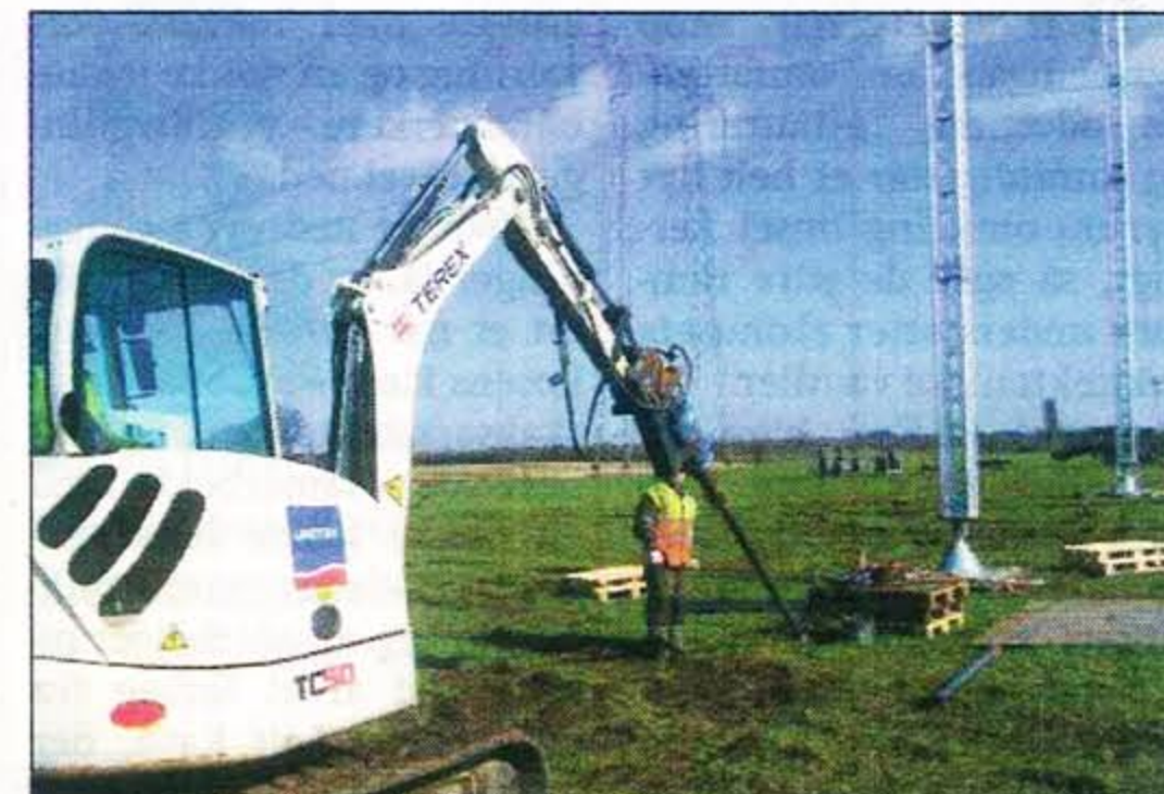
"Kæmpe-skruetrækker" i sving. En gravemaskine skruer pæle ned til trækankre, som kan tøjre de midlertidige master, mens højspændingsforbindelsen skifter fra de gamle gittermaster til de nye Eagle-master.
