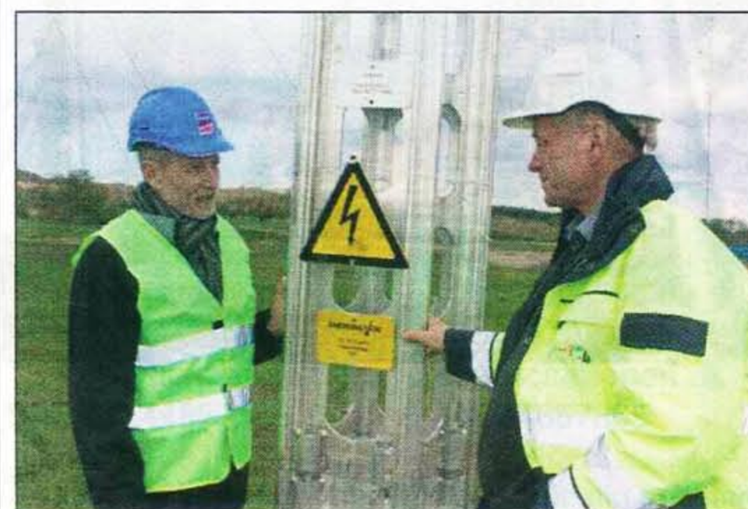
Teknikersnak om luftledninger og jordankre. Ingeniør Arne V. Anov fra Uretek (til venstre) og linjemester Kurt Pedersen fra Energinet ved en af de midlertidige aflastningsmaster.
