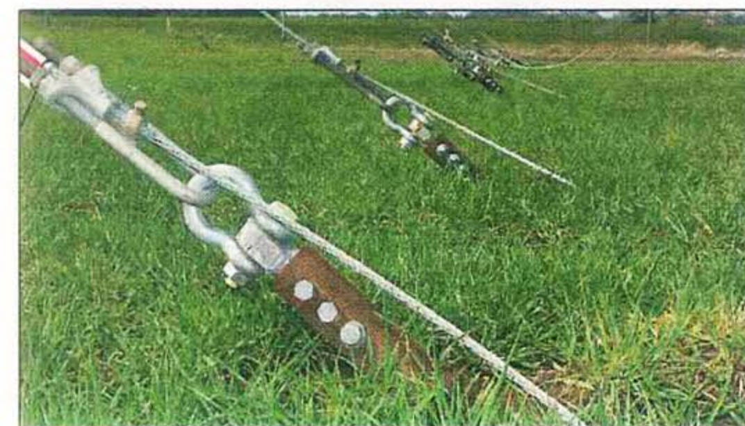
Skruerpælene står tæt ved Rødekro. Cirka 80 gange har en entreprenørmaskine som overdimensioneret "skruetrækker" skruet en pæl i jorden til at holde de midlertidige aflastningsmaster.
