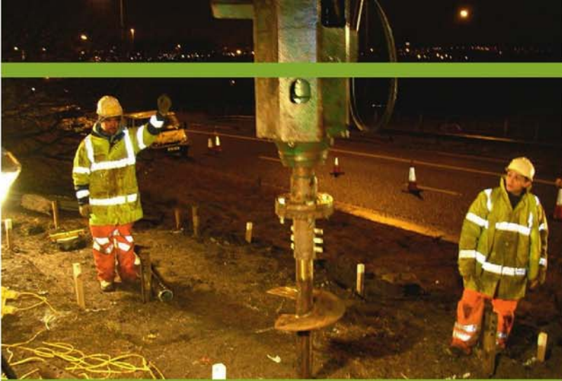
Fundamentboring ved nattetide.
